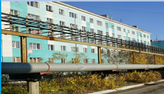
Замена тепловых и водопроводных сетей по ул. Матросова
